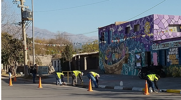
CAAC vista de frente. Colocación de retardadores en Avenida Hipólito Irigoyen.
